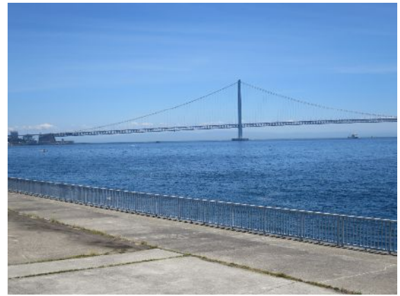
明石海峡大橋
